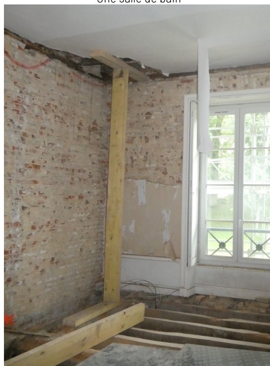
Structure de plancher bois et murs en briques mis au jour
