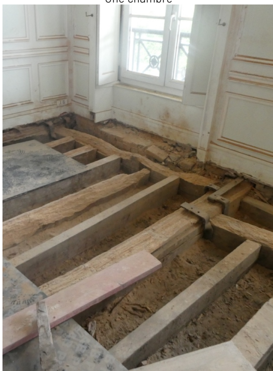
Structure de plancher bois et murs en briques mis au jour
