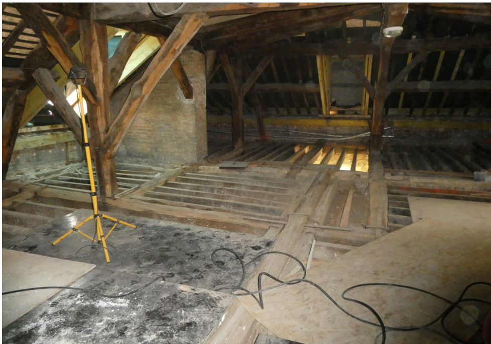
Structure de plancher mise au jour
