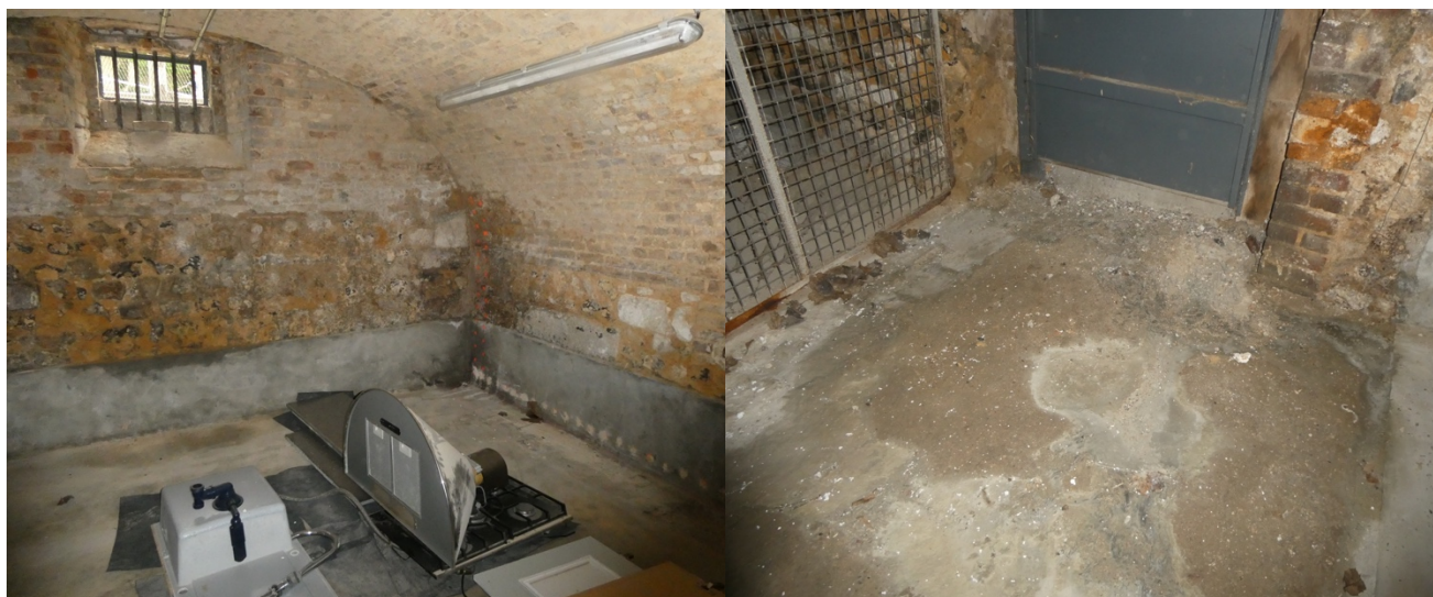
Nouvelles auréoles sur les maçonneries d'élévation et au sol
